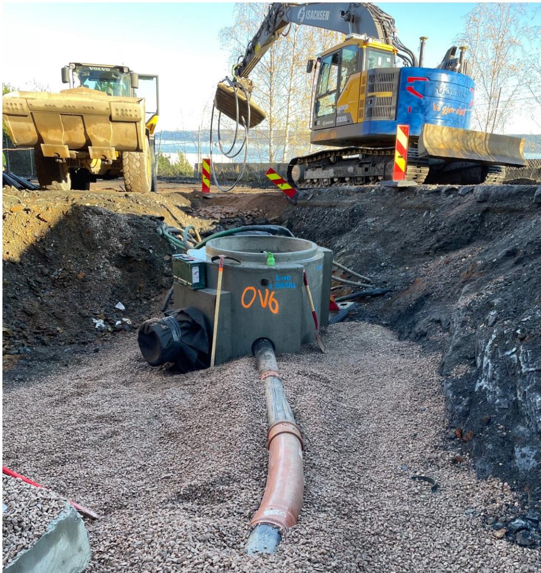
Figur 6 Også på Vaterlandsveien i Slemmestad ble det i 2022 lagt fossilfrie overvanns- og avløpsrør fra Pipelife.
