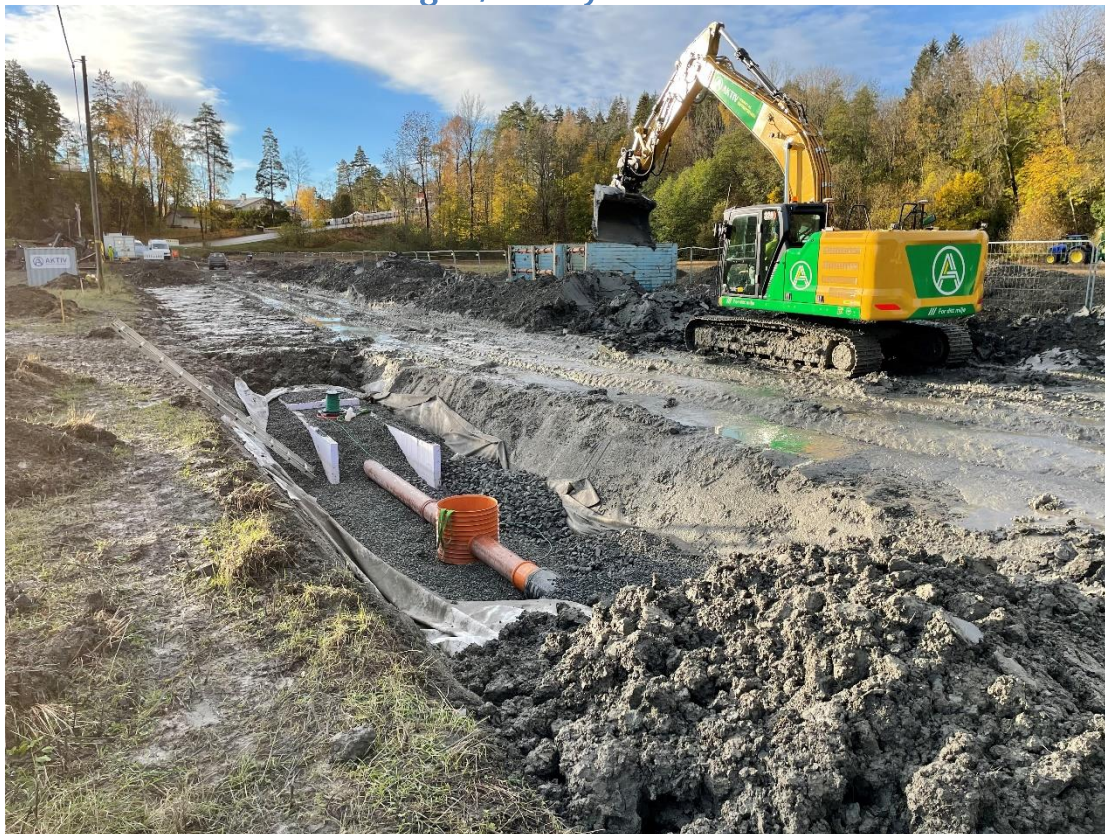
Figur 5 På Petersrønningen er det sanert to pumpestasjoner og lagt 600 m ny trase for overvanns- og avløpsledning. Prosjektet har vært Askers første pilot for utslippsfrie bygge- og anleggsplass. Enova har bidratt med støtte både til elektriske anleggsmaskiner og ladeløsningen med stasjonær og mobil battericontainer.
