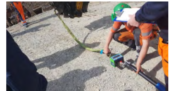
Uttesting av stikkledninger i varerør (Drammen, Asker, Lier)
