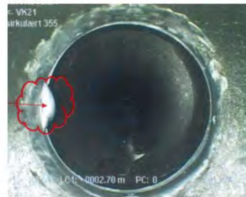
Sikre tette vannledninger med elektromuffesveis (Oslo, Bærum)
